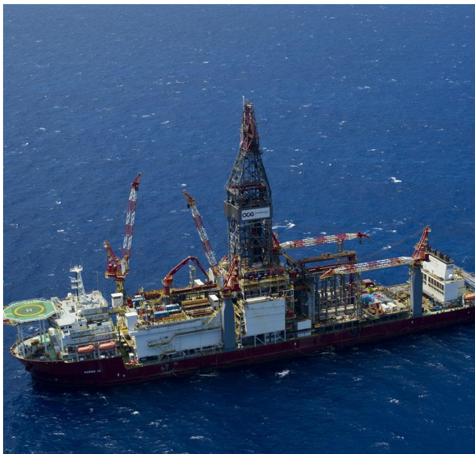
Figura 4 – Plataforma de Torre de Perfuração Móvel
