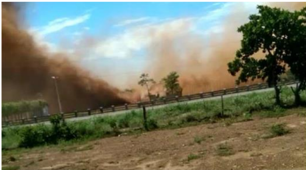
FIGURA 1 - IMAGEM DO INCIDENTE NO GASODUTO DE TRANSPORTE LATERAL CUIABÁ EM 2021,– VISTA DA RODOVIA BR-07010
