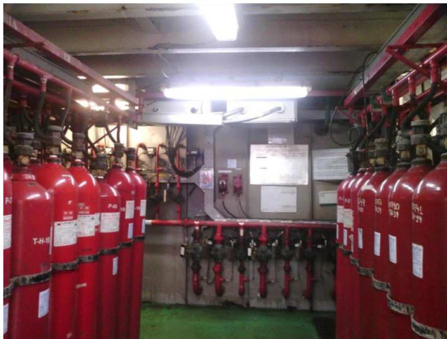
FIGURA 6 – FOTO PARCIAL DA SALA DOS CILINDROS DE CO 2 DA P-19.
