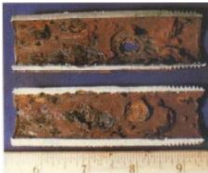
Figura 9 – Tubo que sofreu corrosão sob depósito
