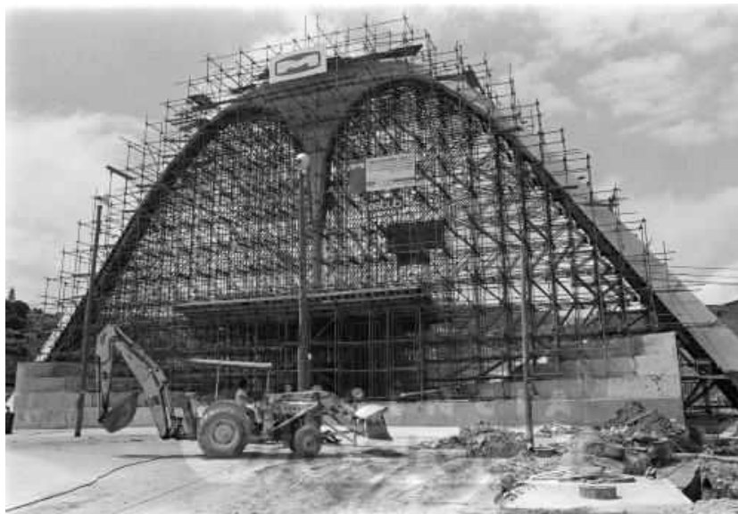
Ilustração 29: Construção da Passarela Professor Darcy Ribeiro, o Sambódromo
