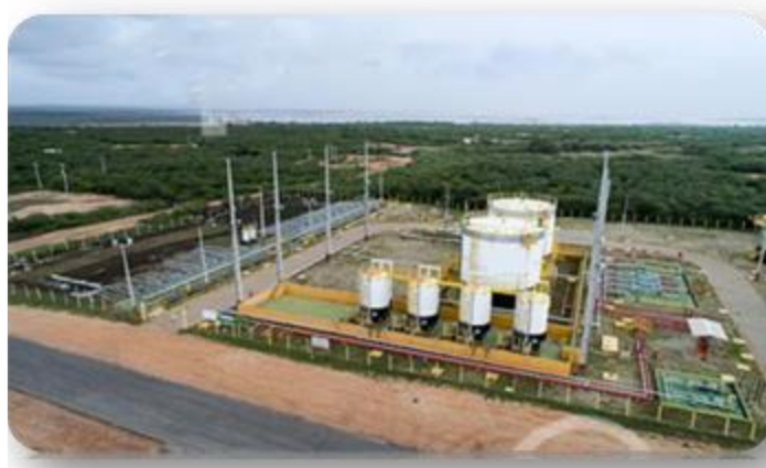
Figura 1: Foto da estação coletora de petróleo utilizada como modelo para elaboração do PRE.
