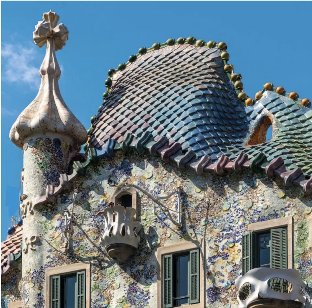
Ilustração 7 - Telhado da casa Batlló
