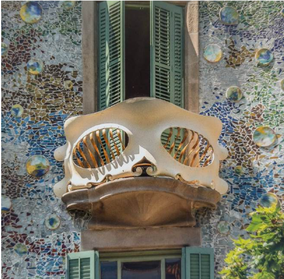
Ilustração 5 - Varanda da fachada
