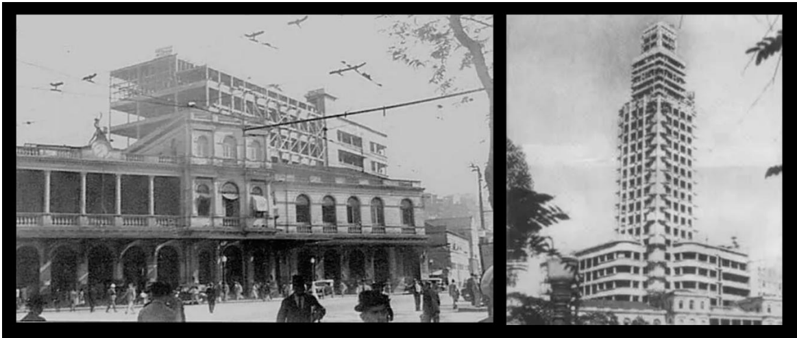
Figura 32- Edifício e relógio da estação em construção
