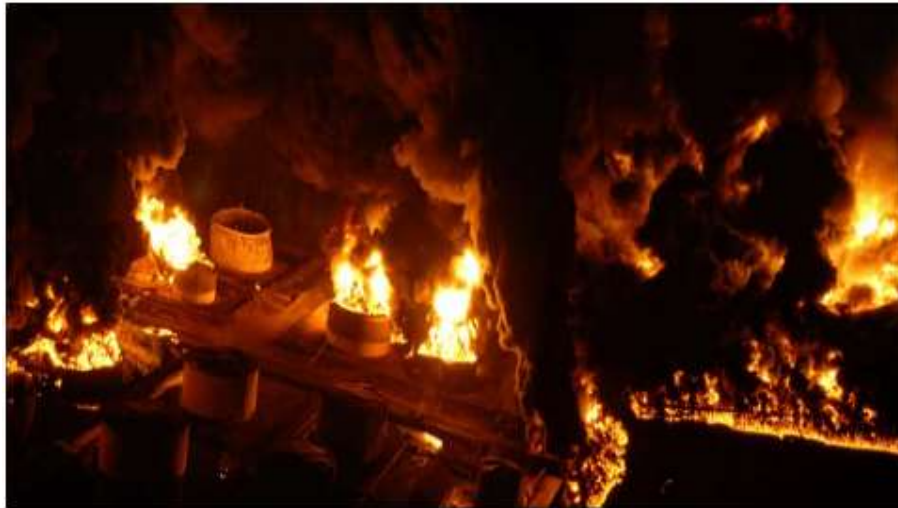
Figura 7 – Incêndio no parque de tancagem da CAPECO
